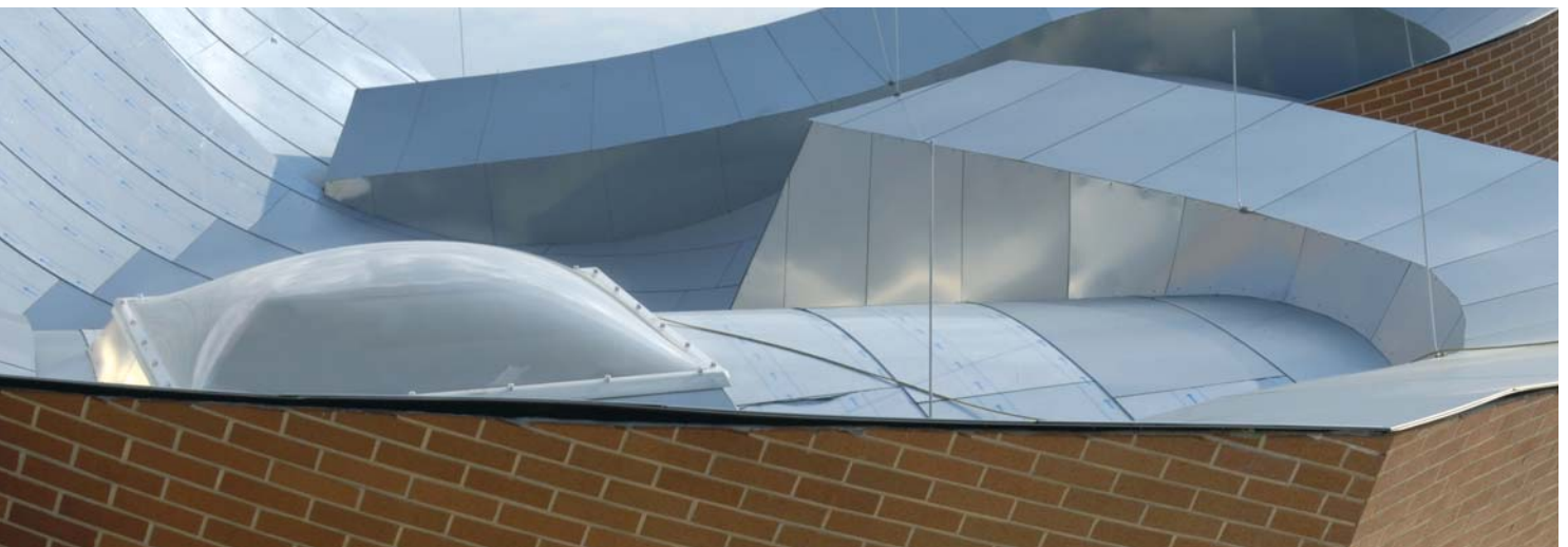
Lichtkuppeln krönen die überdimensionierten Lichtschächte, über die Tageslicht in die fensterlosen Räume gelangt.
