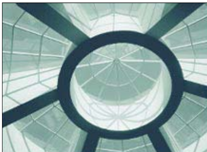
Bild E.47 Oberlichter am San Diego Airport /E.48/
