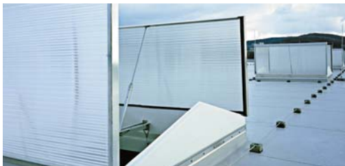
Spezielle Doppelklappen sind besonders gut zur großflächigen Lüftung geeignet.
