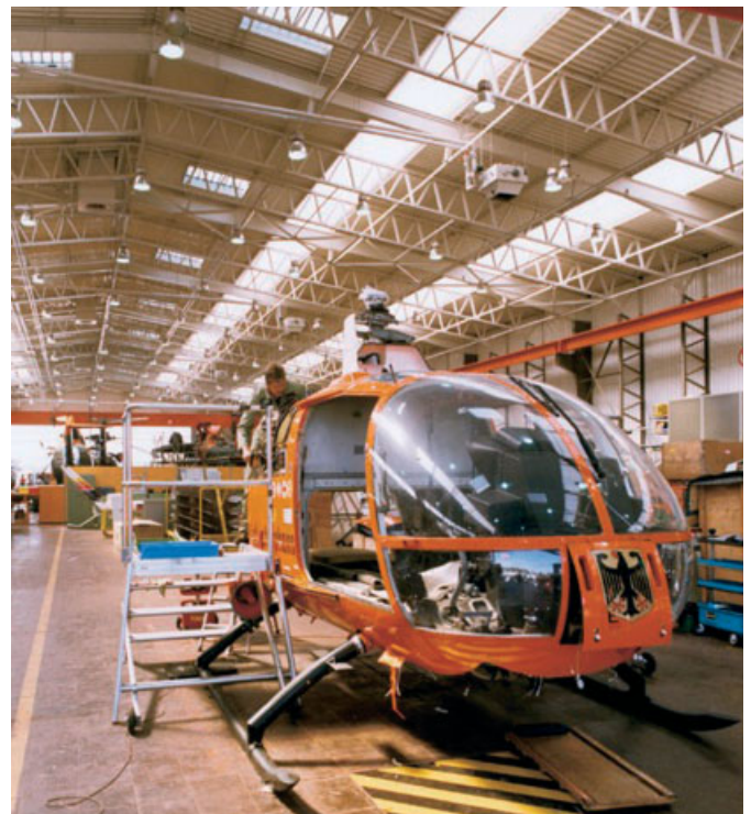
Bild 2. Kombination aus Lichtkuppeln, Lichtbändern und RWA-Geräten in einer Hubschrauberwartungshalle Fig. 2. Combined use of individual rooflights, continuous rooflights and smoke and heat exhaust ventilators in a maintenance hall for helicopters
