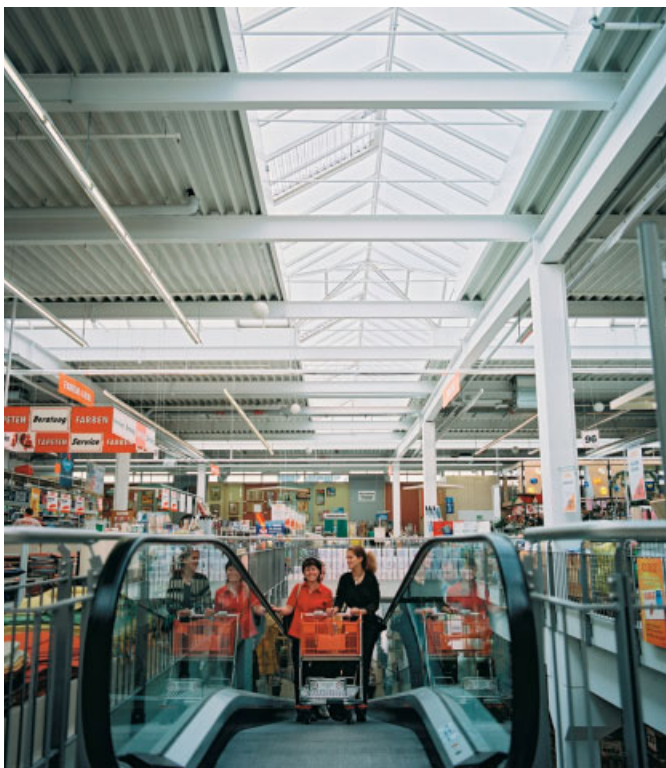
Bild 1. Ein Satteldachoberlicht beleuchtet die Rolltreppen und die Hauptverkehrswege eines Kaufhauses Fig. 1. A ridgeroof skylight illuminates the escalators and the main aisles of a shopping center
